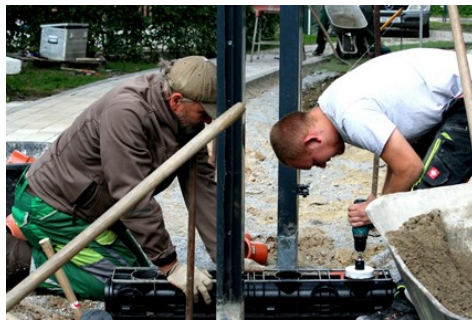
Akkurates Arbeiten auf der Baustelle am neuen Paul-Gerhardt-Heim in GM-Hütte
